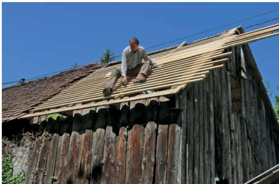
Gospodar domačije Žagni ob Štebrščici na Lipsenju pri sanaciji strehe žage, krite z bobrovcem. (© Jan Petrič)
